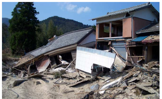
写真-3 東郷町での家屋損壊状況
