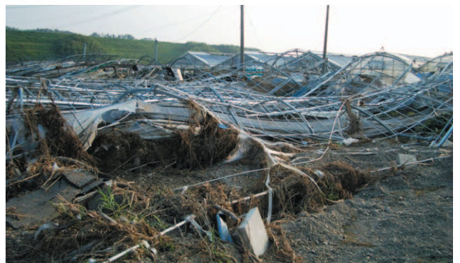
写真-4 西都市でのビニールハウス損壊状況
