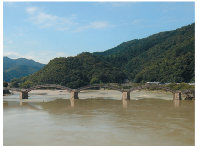
写真-5 台風被害後の錦帯橋全景(上流側より)(岩国市観光課錦帯橋担当室:提供)
