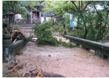
写真-10 白糸川の増水により濁流した大聖院参道（宮島町総務課：提供）
