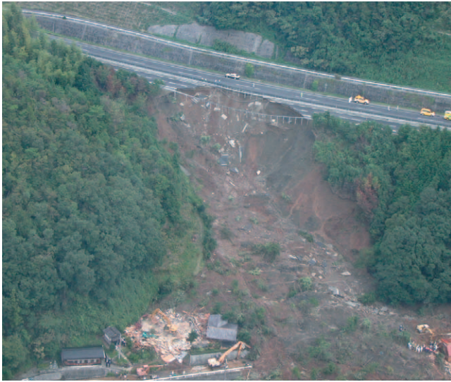
写真-1 山陽道のり面崩落状況(正面)(国土交通省中国地方整備局:提供)
