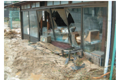
写真-11 土石流の流入により被災した商店街（宮島町総務課：提供）
