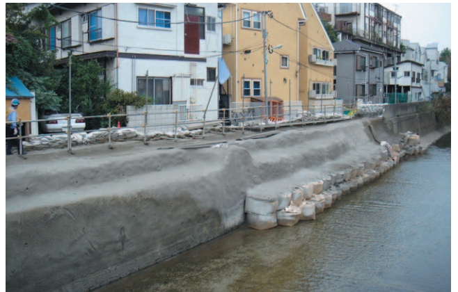
写真-2 妙正寺川北原橋上流右岸護岸修復旧写真
