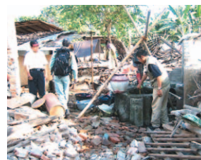
(a) 電動ポンプの塩ビパイプが0.7mほど突き上がる 南緯 7deg. 57.416min 東経 110deg. 23.186min (図-1 中 8)
