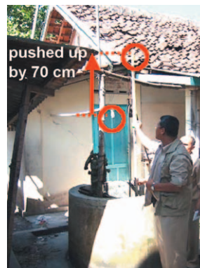
(a) 電動ポンプの塩ビパイプが0.7mほど突き上がる 南緯 7deg. 57.416min 東経 110deg. 23.186min (図-1 中 8)
