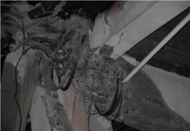
写真-6 定着のためのディテールが不適切で破壊している事例(経済科学大学(STIK Kerja Sama, RC3F - 6F))(図-1 中 ④)
