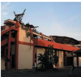
写真-5 ジョグジャカルタスポーツセンター (RC3F) の被害 (図-1 中 3)
