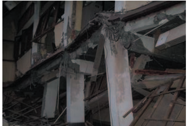
写真-6 定着のためのディテールが不適切で破壊している事例(経済科学大学(STIK Kerja Sama, RC3F - 6F))(図-1 中 ④)
