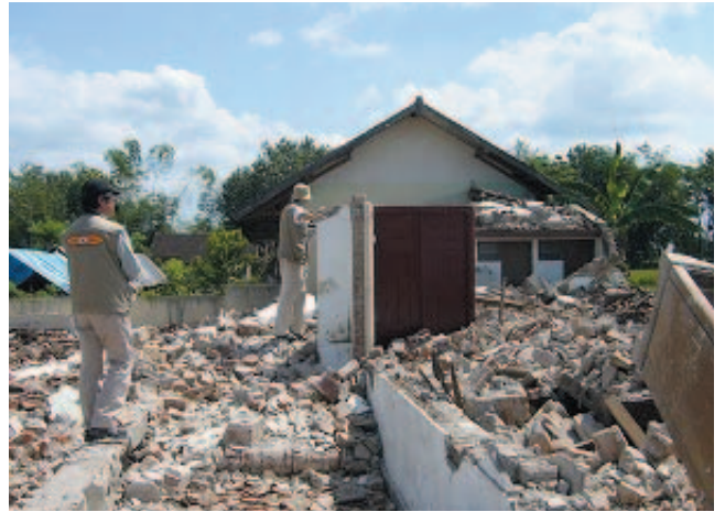
写真-4 無鉄筋煉瓦造建物の被害 (Klaten 県 Pesu) (図-1 中 24)
