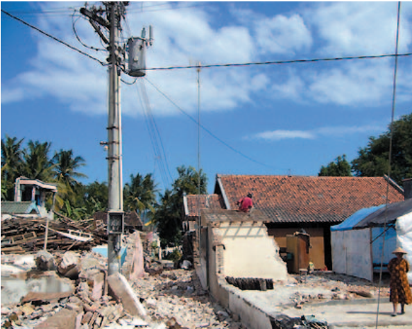
(a) Bantul 県 Imogiri 地区 (図-1 中 10)
