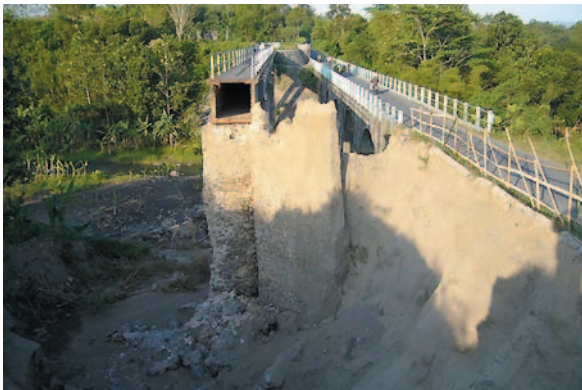
(a) 水路橋全景
