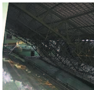
写真-5 ジョグジャカルタスポーツセンター (RC3F) の被害 (図-1 中 3)
