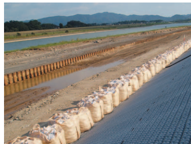
写真-5 薩摩川内市中郷地先の損傷した川内川右岸側護岸の仮復旧後の様子(2006年8月22日撮影)
