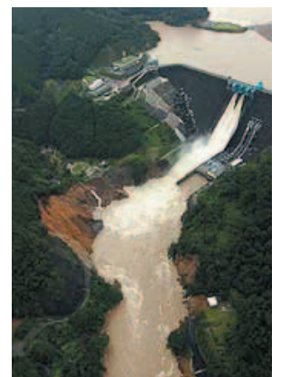
写真-1 洪水時の鶴田ダムの様子(23日14時58分、南日本新聞社ホームページより)
