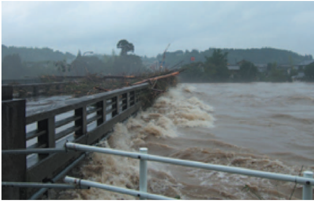
写真-2 川内川の宮都大橋の洪水時の様子(中央部ではすでに部分閉塞しているようにも見える)(国土交通省川内川河川事務所ホームページより)
