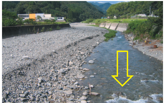
写真-7 球磨川支川の小川下流部に大量の砂礫が溜まっている(球磨村、2006年8月21日撮影)
