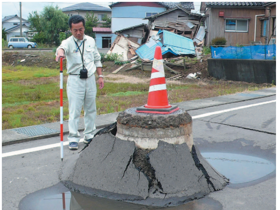
6 マンホールの浮き上がり(規矩大義氏(関東学院大学)撮影)
