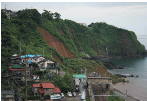
5 斜面崩壊による線路の埋没(信越本線青海川駅)
