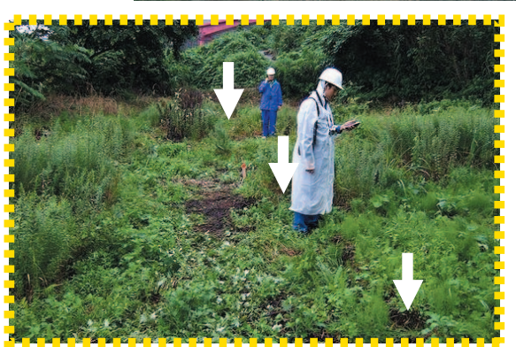
写真-6 青海川駅背面の斜面崩壊：海岸段丘の地層の境界（黄色矢印）。すべり残しの部分も（白矢印）（写真提供：朝日航洋）
