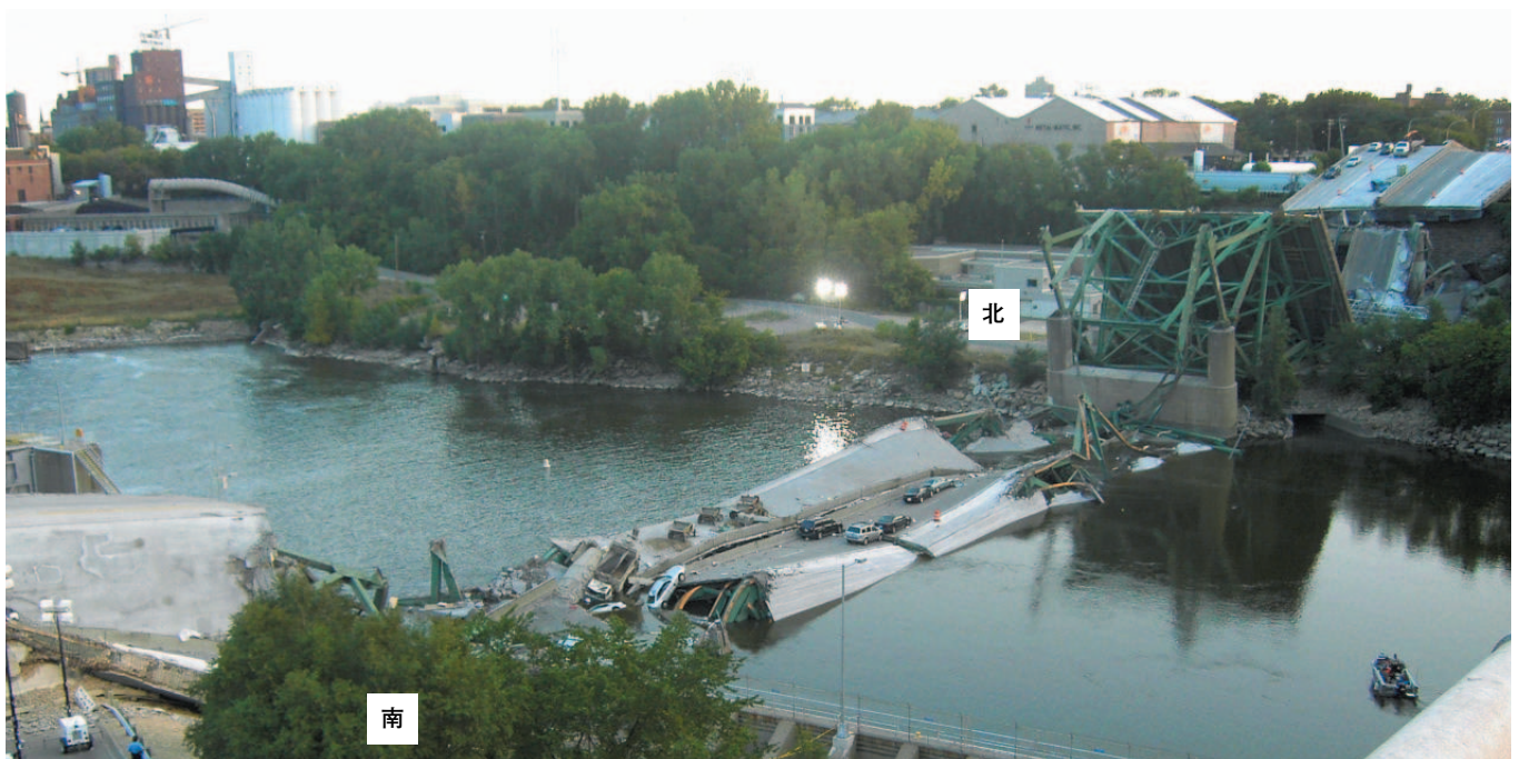
写真-4 崩壊翌日。隣接する 10 番街橋より北を望む 5)
