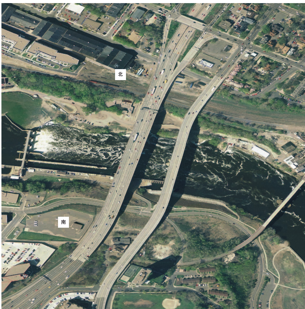
写真-1 I-35W ミシシッピ川橋梁(左)と10番街橋(右)(2004年) 3)
