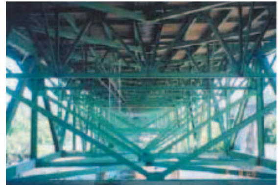
写真-3 トラスの主構と床組 4)
