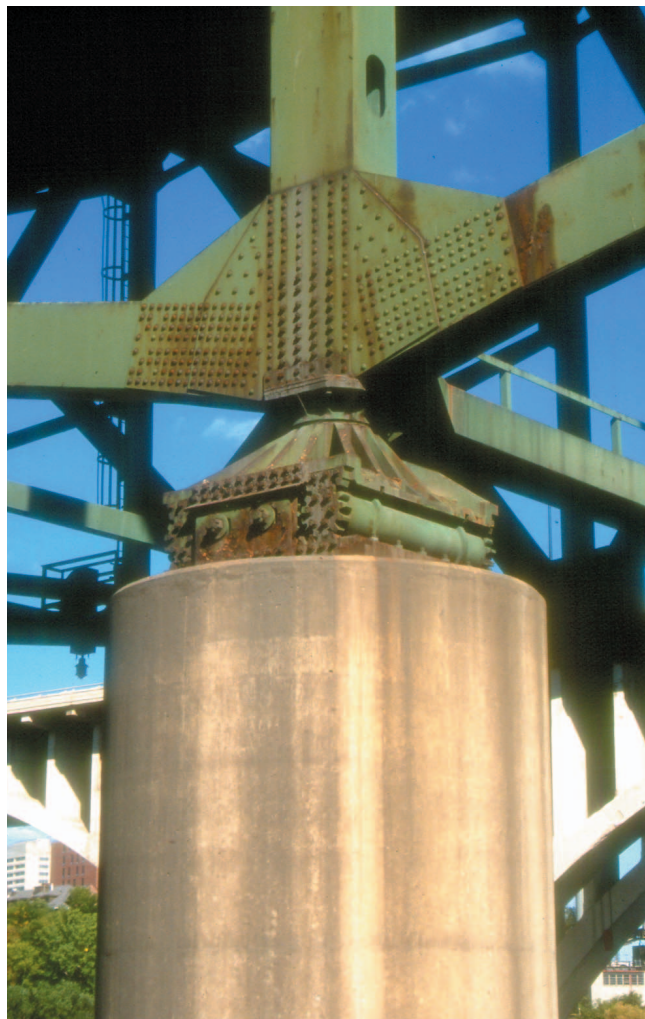
写真-5 南西方橋脚とガセットプレート(1996年) 6)
