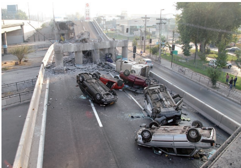
写真1 サンティアゴ環状高速道路エチェベツ橋 (写真提供: アフロ)
