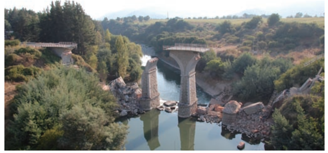
写真3 長クランドマークとしてチリ国民から愛されてきたクラロ橋の落橋
