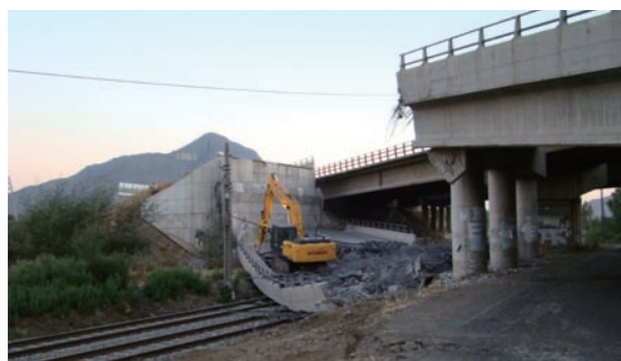
写真2 1990年代半ば以降に建設された橋(左)が落橋し、それ以前に建設された橋(右)がほとんど無被害であった一例(チリ公共事業省による)
