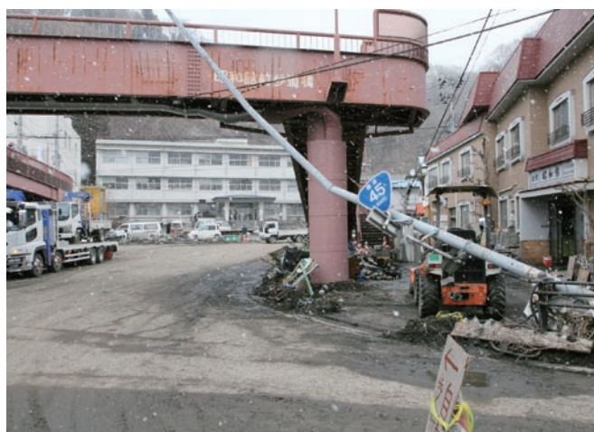
照明柱の被災 (宮古市役所付近国道45号)
