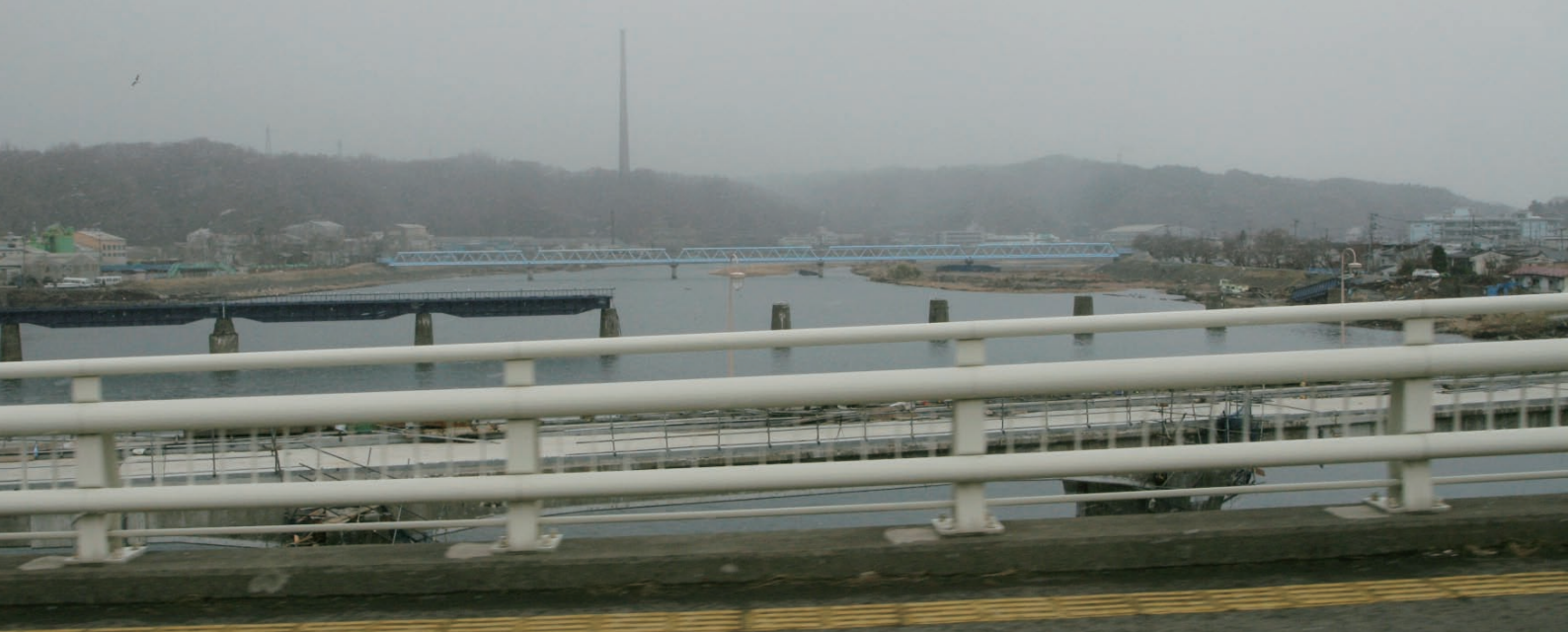
閉伊川に架かる鉄道橋の被災 (JR山田線)
