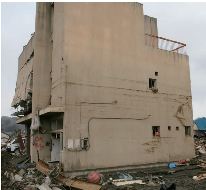
津波痕跡 (田老地区長内川右岸側) 2階天井まで水没したと思われる
