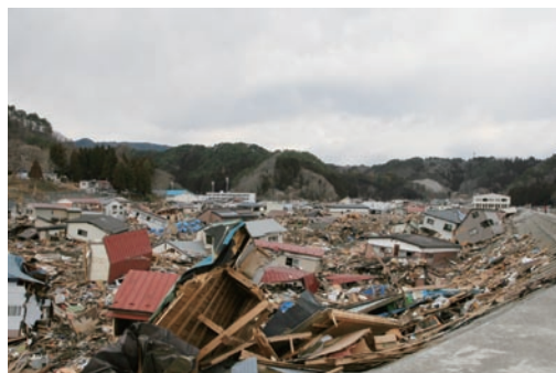
被災状況 (田老地区長内川右岸側)
