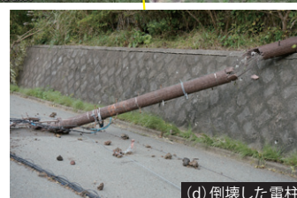
(d) 倒壊した電柱
