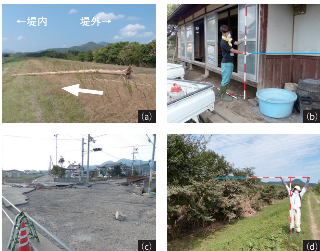
図5 河川水の流入箇所、民家浸水痕跡、道路損壊((a)~(c):2013年9月23日撮影)および堤防未整備箇所(d):2013年9月25日撮影)
