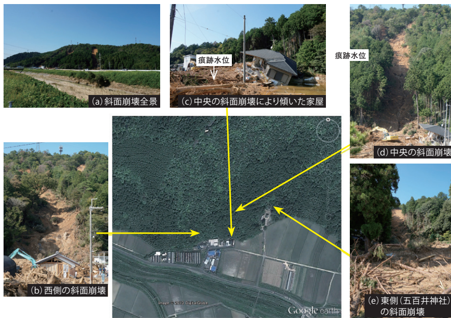
図6 栗東市下古山地区の斜面崩壊 (2013年9月21日撮影)
