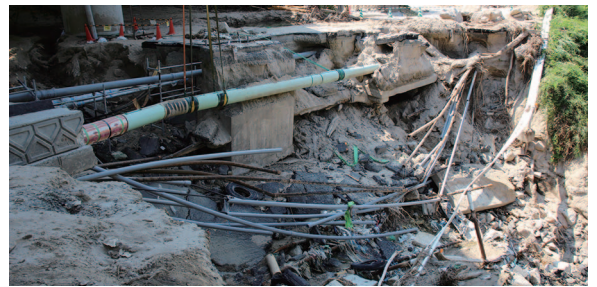
写真5 熊野道路基礎部の被災(上: 河川を流下した土石流が基礎部分をえぐる、下: 路面流出によってむき出しとなった埋設物)
