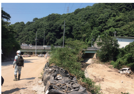
写真4 県道34号線昭和入口交差点付近から広島熊野道路 (高架) を望む (左: 写真右の河川 (中央植生右) が土石流で埋まり左の道路にあふれる。右: 広島熊野道路付近。残された被災車両がみえる)
