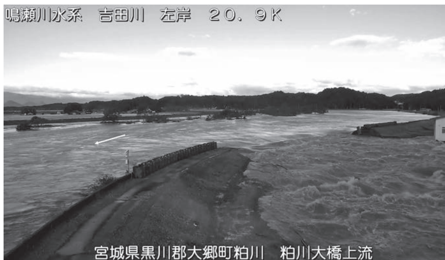
写真1 吉田川の破堤 (提供: 国土交通省北上川下流河川事務所)
