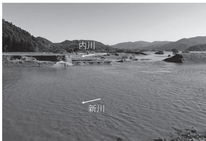
写真2 阿武隈川支川内川・新川合流部における破堤
