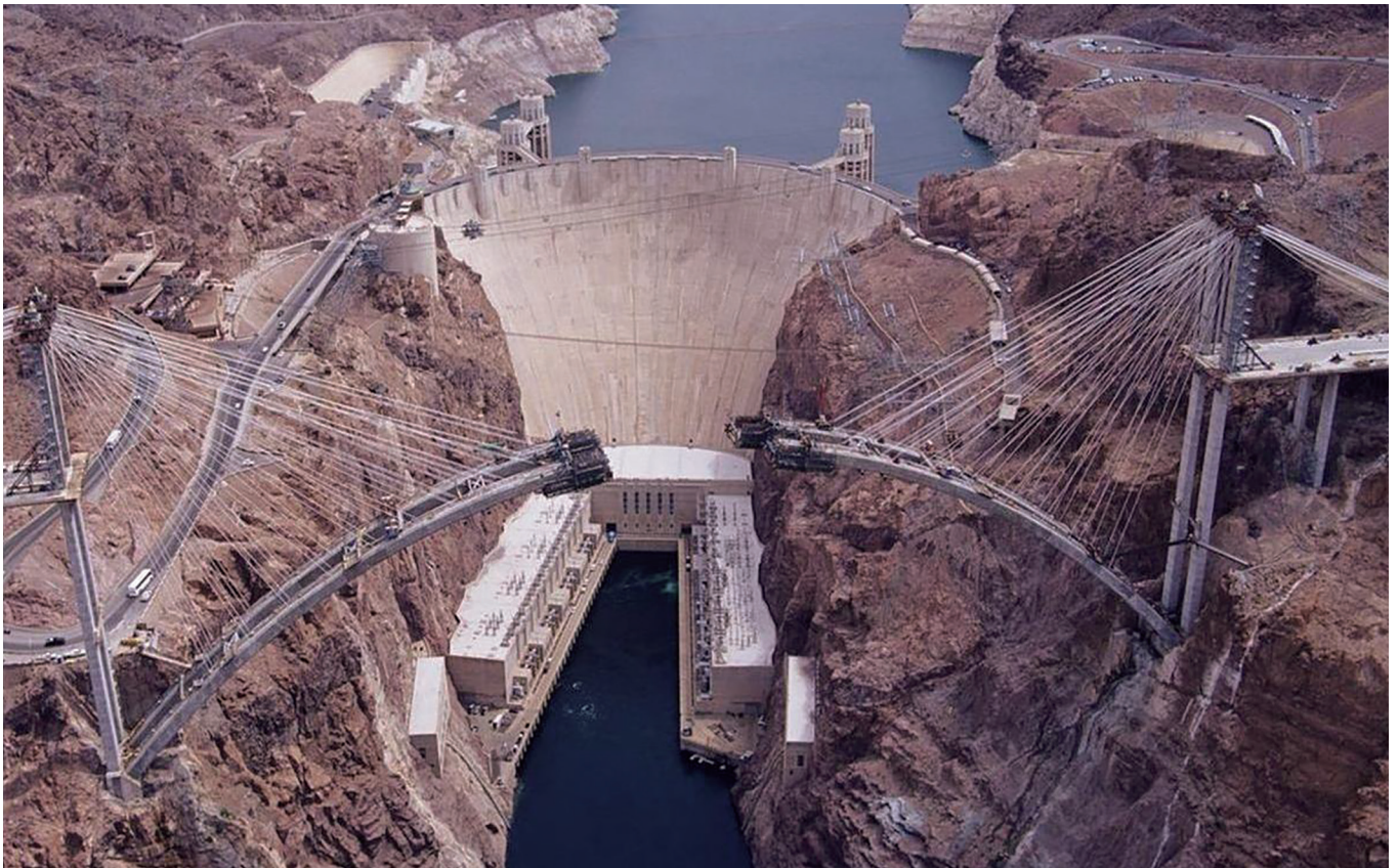
写真1 コロラドリバー橋 (提供：(株)大林組)
