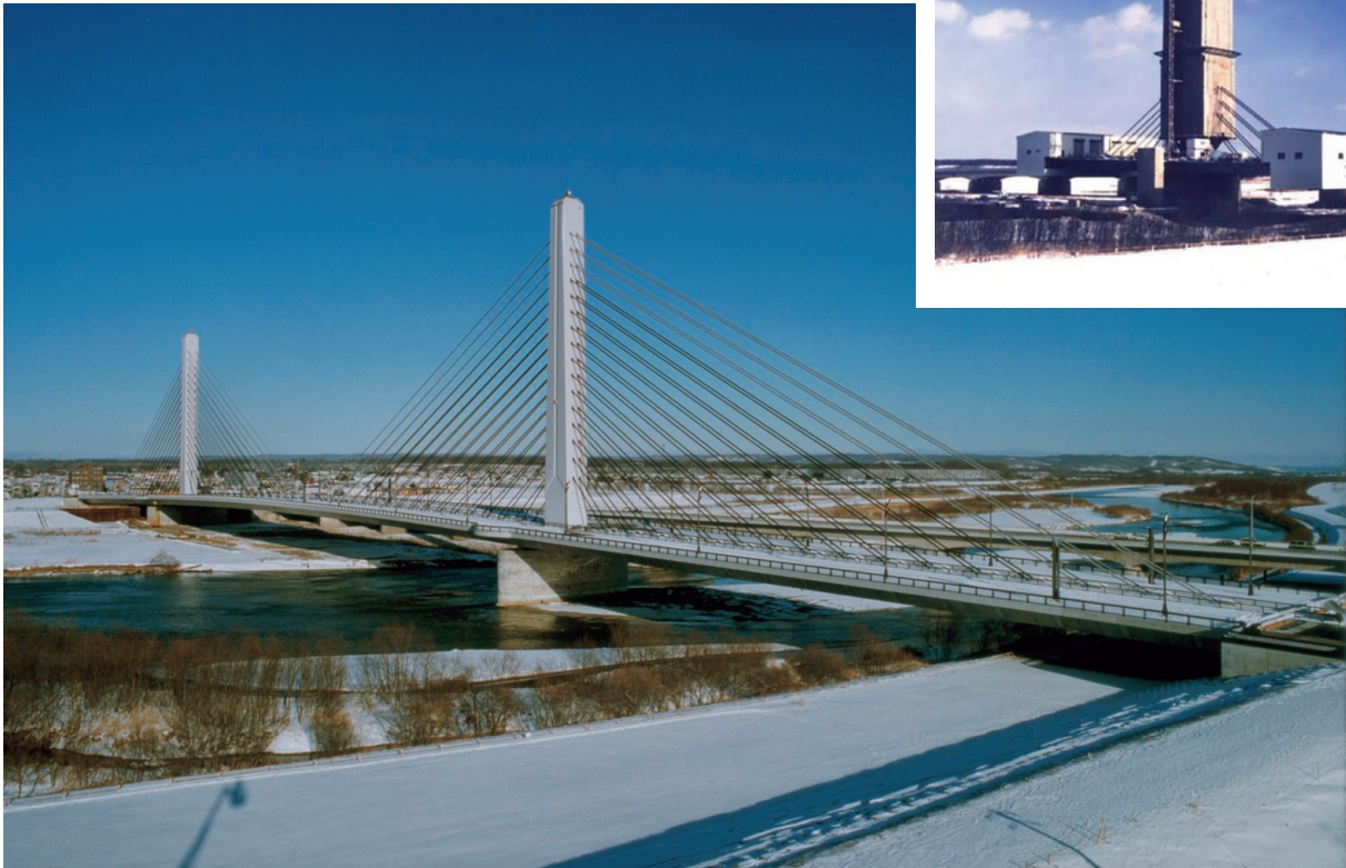
写真1 十勝大橋全景
