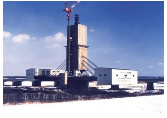
写真2 建設中の十勝大橋
