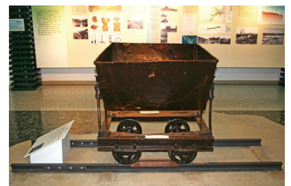
2000(平成12)年出土の分水路工事に使われた鍋ト口(土運搬車)
