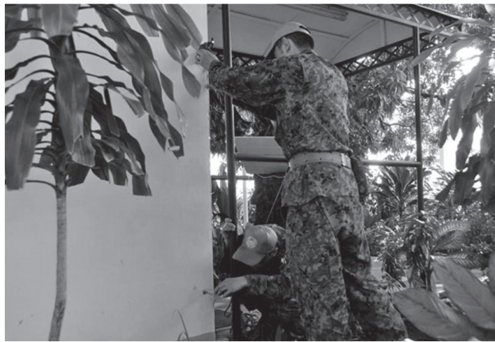
写真1 国連施設の耐震診断の様子
