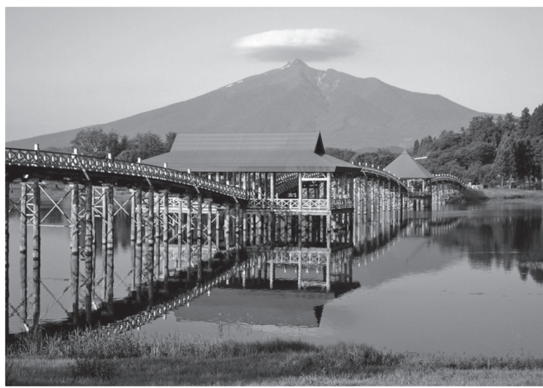
写真2 木造橋梁：鶴の舞橋（提供：鶴田町役場）
