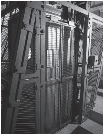
写真3 主塔内のエレベーターの外観
