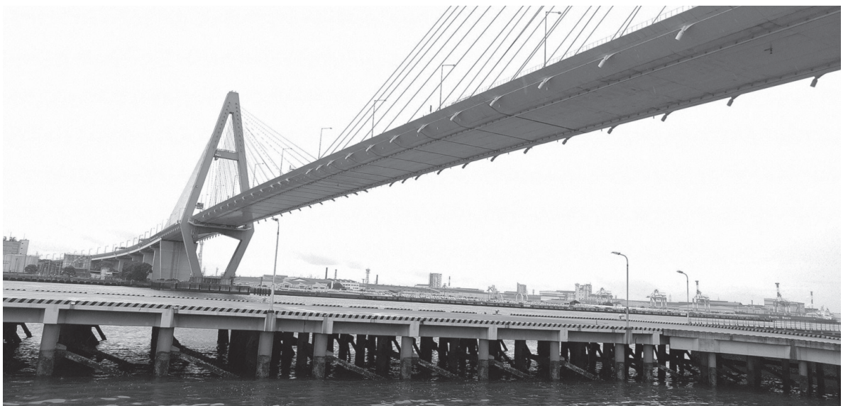
写真1 名港東大橋 (左に見えるのが主塔)
