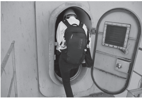
写真2 主塔下部にある管理者用出入り口
