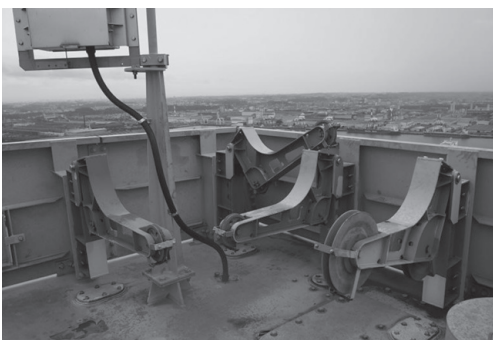
写真4 主塔頂部に設置された滑車
