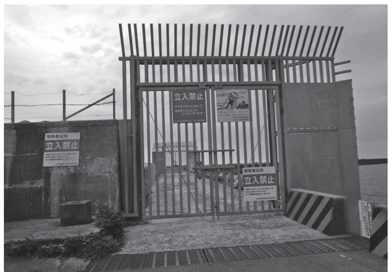
写真1 西防波堤入口門扉 (提供: 新潟県交通政策局港湾整備課)
