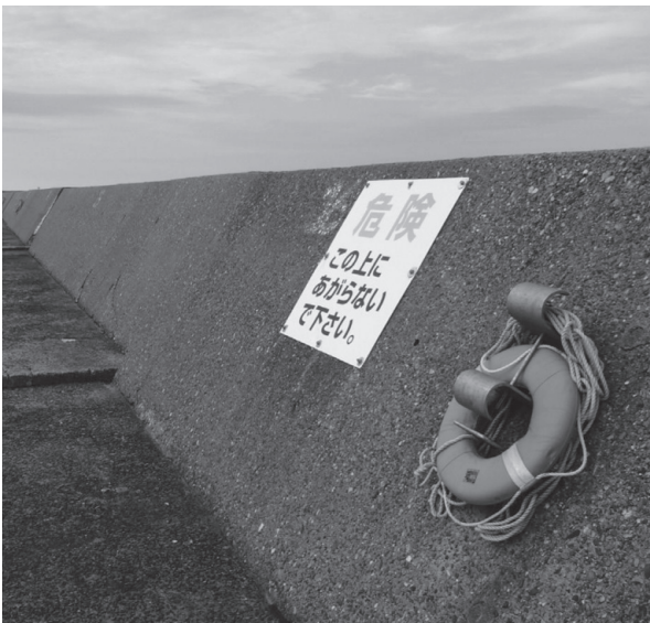
写真3 釣り場に救命浮輪の常備（提供：新潟県交通政策局港湾整備課）
