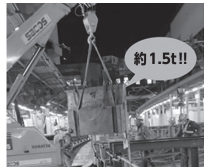
写真3 コンクリート部材の撤去 (提供: JR 東日本)
