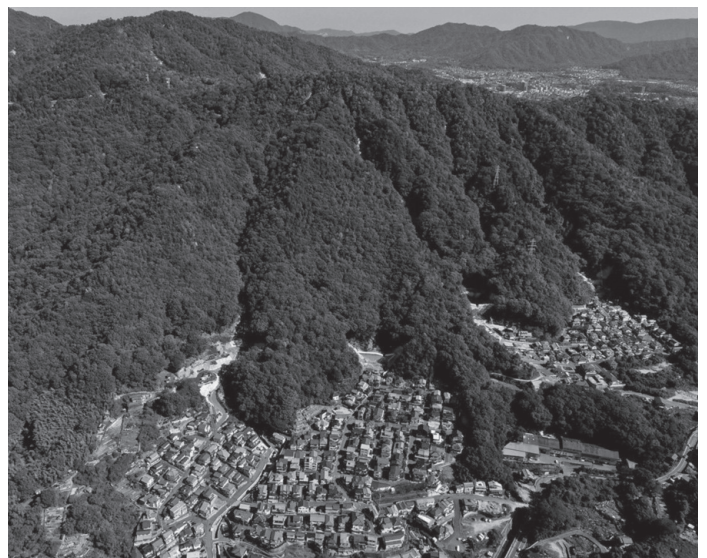
写真1 山々の谷間に迫る住宅地（矢野東地区〔広島市安芸区〕） （提供：国土交通省）
