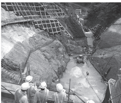
木戸ヶ沢貯水池保全施設（サブダム）のコンクリート打設中。写真奥がかん止堤。
