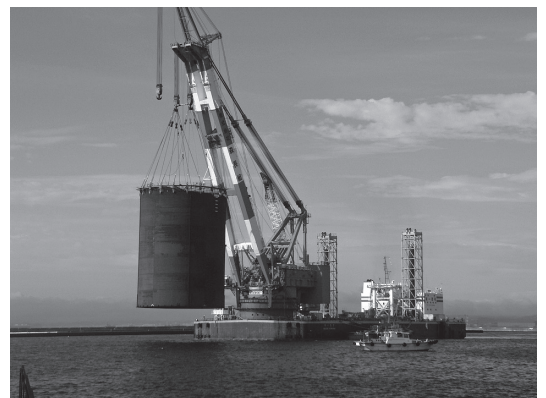
写真2 据え付け中の鋼板セル（提供：国土交通省）
