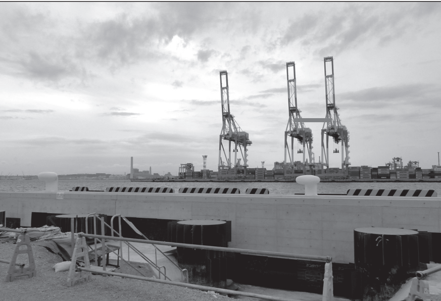
写真1 建設中のMC-3岸壁（手前）と運用中のMC-1、2岸壁（奥）
