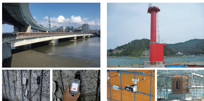
●補修効果の健全性確認 ●塩害による腐食劣化の確認 ●飛来塩分による腐食環境の把握 ●塩害による腐食劣化の確認 図3 橋梁の維持管理への適用例 図2 灯台の維持管理への適用例
