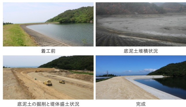
図4 掘削と盛土の同時施工例
