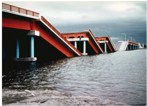
写真1 地震で落橋した昭和大橋(1964年)
