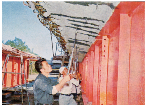
写真2 昭和大橋でのひび割れ注入状況
