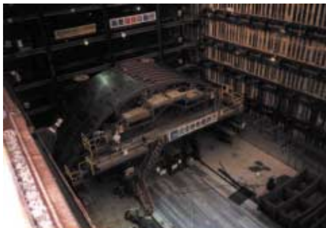
写真-3 スライドセトル組み立て状況
