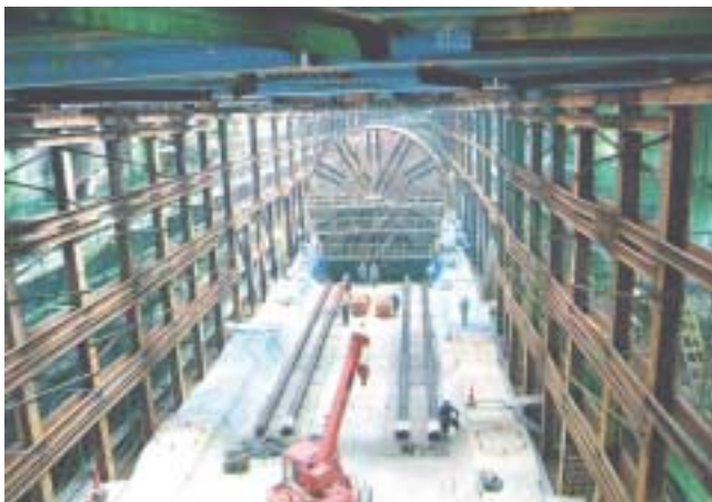
写真-2 移動中のシールド機
