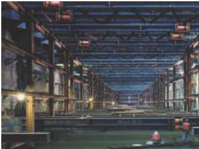
写真-1 水張り足場工法による作業状況
