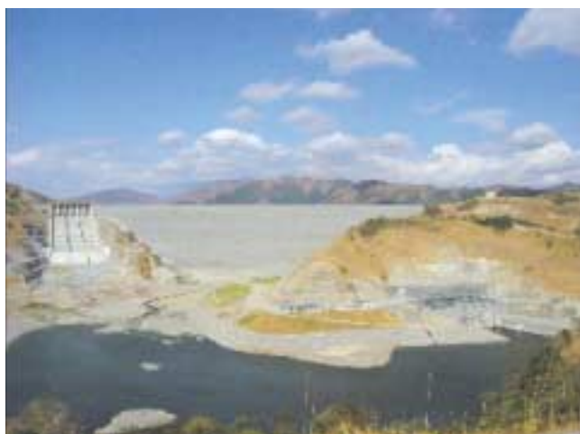
写真-1 サンロケ水力発電所全景
