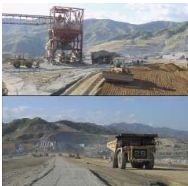
写真-4 ダム盛立状況 (ダム左岸より撮影)
