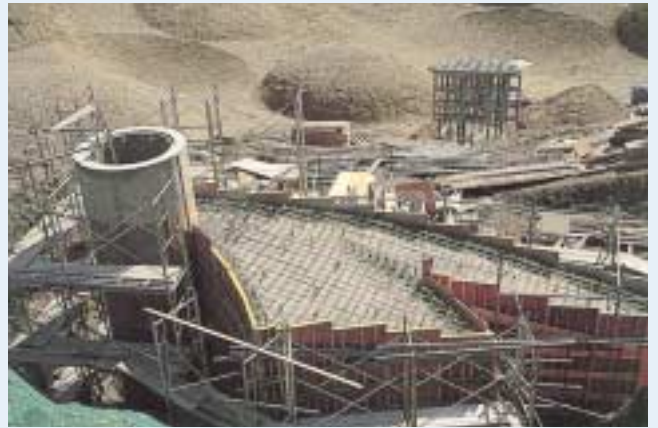
写真-5 養老天命反転地の施工状況
