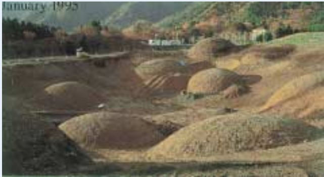
写真-4 養老天命反転地の施工状況
