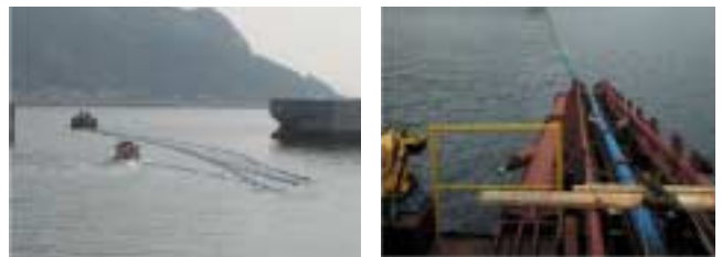
写真-1 施工状況（左：取水管曳航 右：取水管敷設）
