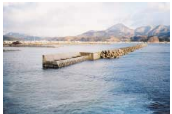
写真-1 斜面スリットケーソン(福島漁港)
