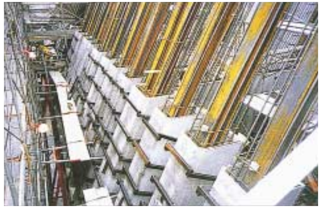
写真-2 スリット部における鉄骨と高耐久性埋設型枠の設置
