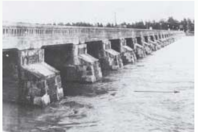
写真-5 瀬田川洗堰
