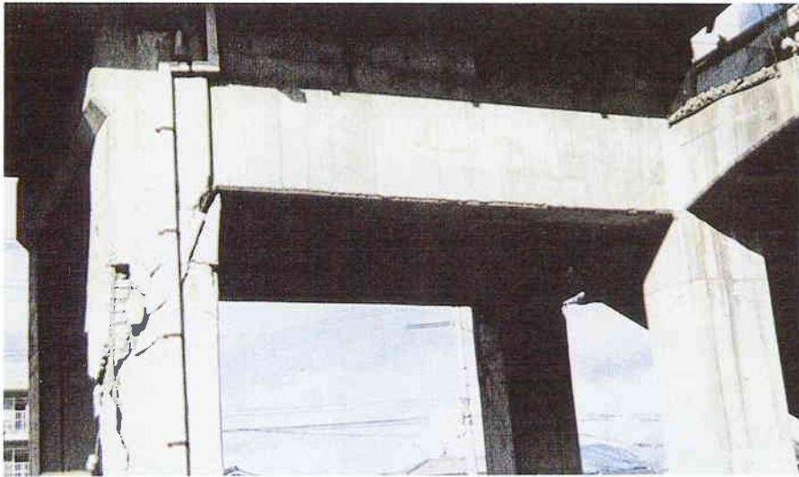
S 6 ラーメン橋台に用いられている 高さの高いはり
