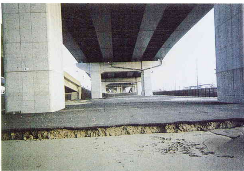
K 10 健全な湾岸線のRCラーメン橋脚
