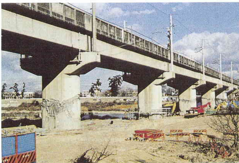
S 9 武庫川橋梁小判型橋脚の全景
