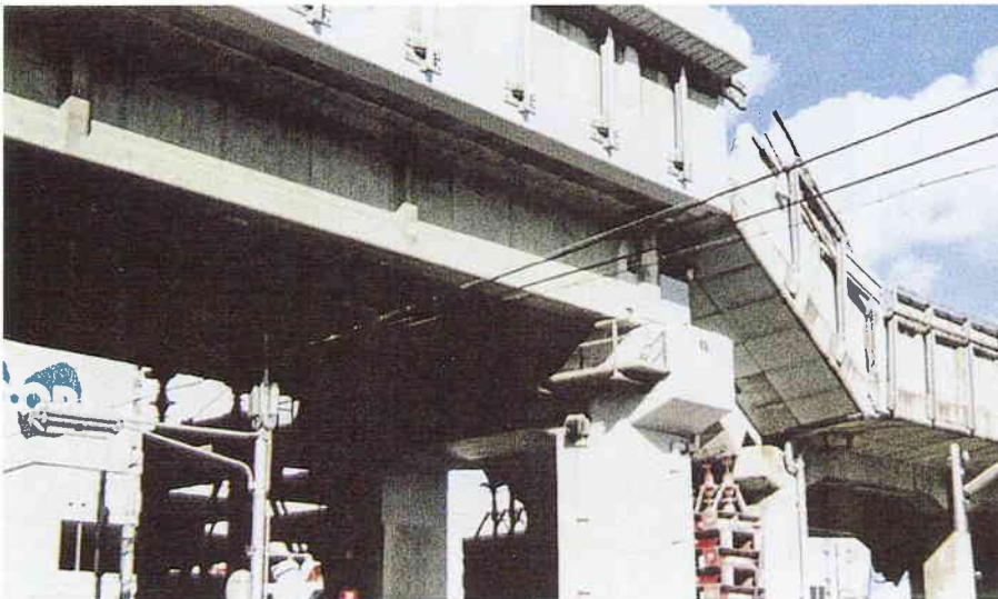
S 8 PC 桁を支える健全なラーメン橋脚
