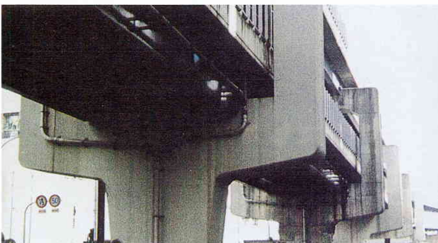
H 1 単柱(壁)式二層ラーメン橋脚
