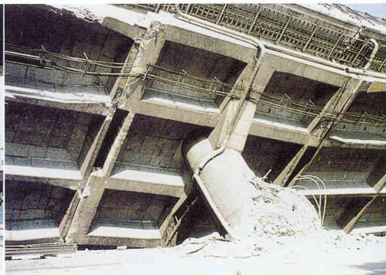
K 8 ピルツ橋脚の倒壊
