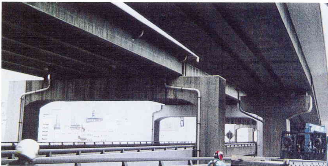
K 9 健全なラーメン橋脚
