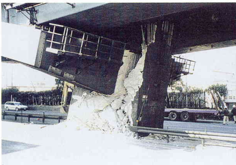
K 7 単柱式矩形橋脚の崩壊
