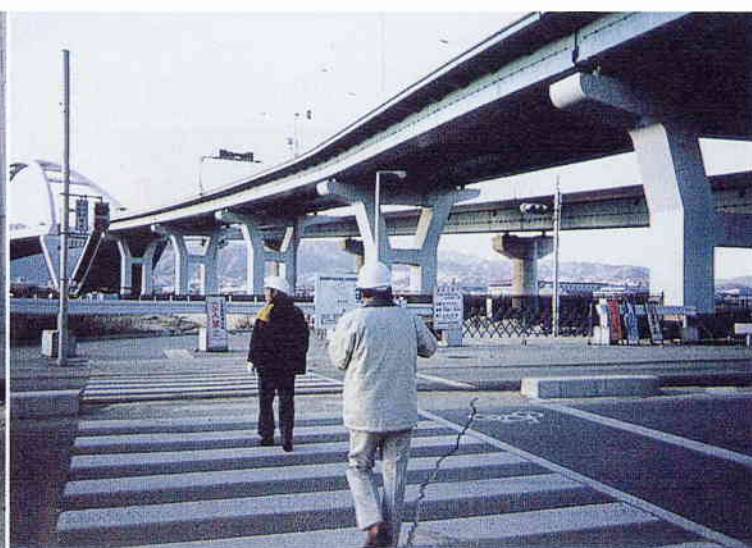
K 11 健全な湾岸線の鋼橋脚
