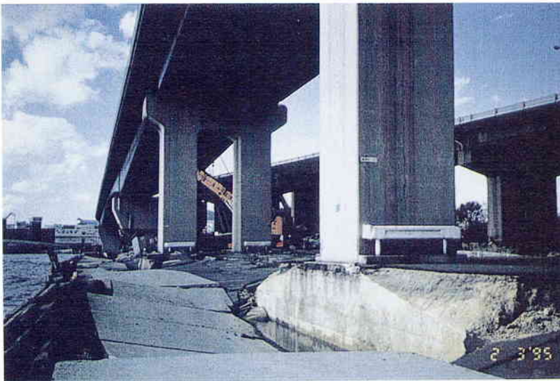
H 1 6 健全なラーメン橋脚
