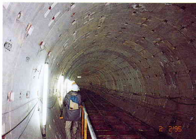
写真-11 関西電力磯辺通シールドトンネルの状況
