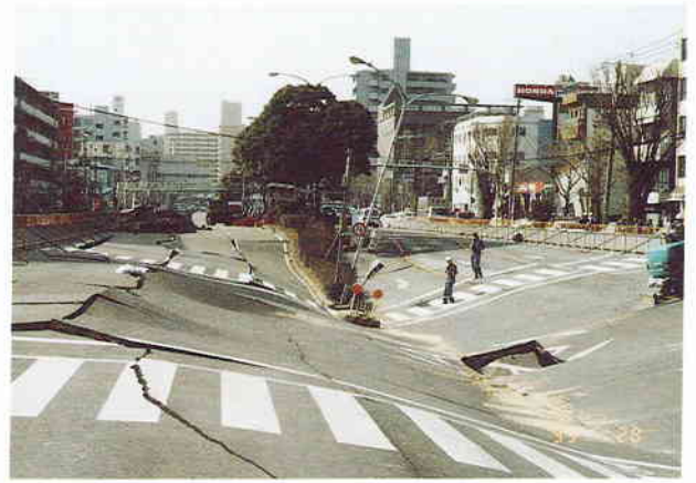
写真-4 大開駅地表面の道路陥没状況
