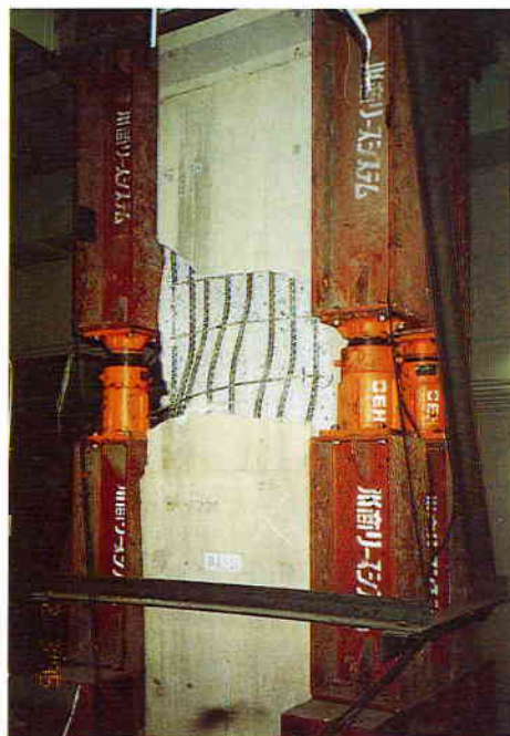
写真-8 神戸市営地下鉄三宮駅舎の中柱の補修状況
