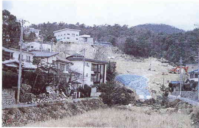
写真-7 仁川の地すべり崩壊全景
