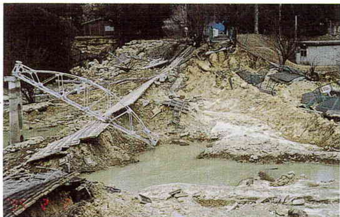
写真-12 ニテコ池堤防の被災状況
