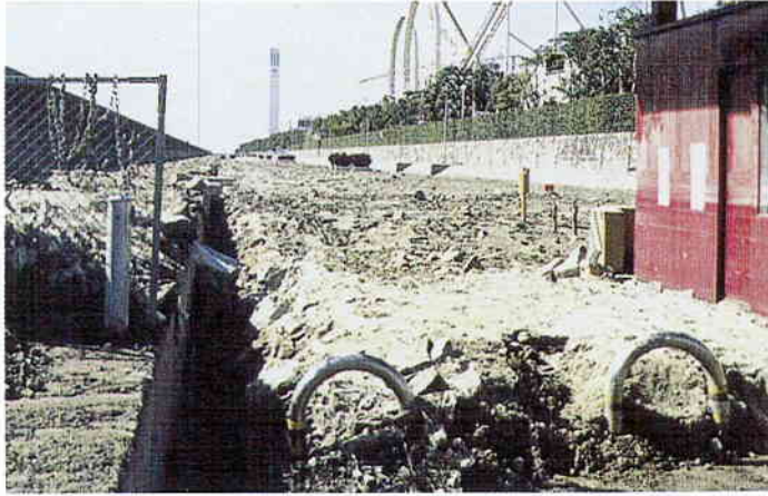
写真-1 ポートアイランドでの噴砂痕
