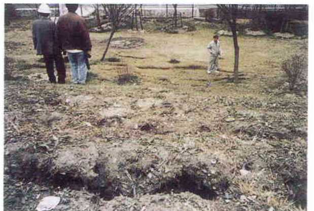
(b) 堤防裏のり面の亀裂
