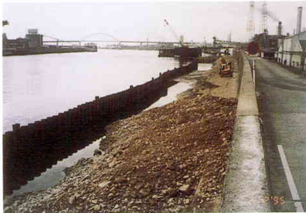
(a) 矢板による緊急漏水防止対策
