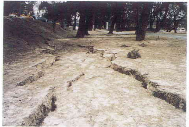
(b) 高水敷の地割れ
