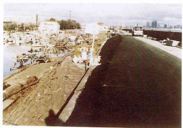
(b) 緊急復旧後の堤防天端の状況
