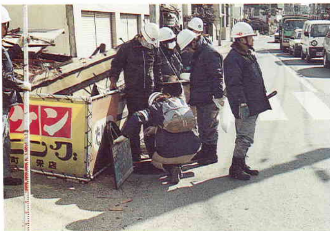
写真-17 下水管の調査
