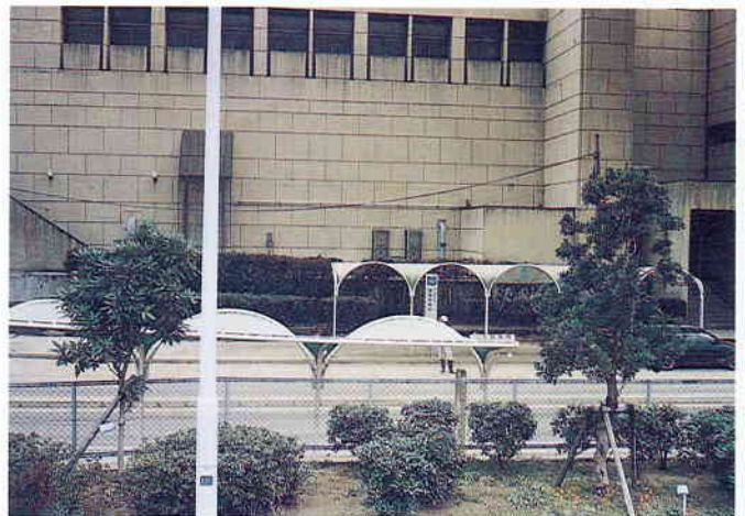
写真-10 健全な南側処理施設
