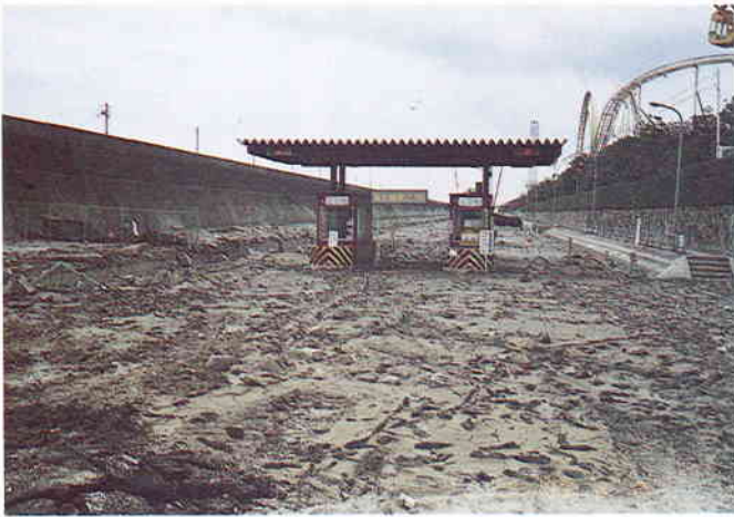
写真-13 ポートアイランドの液状化
