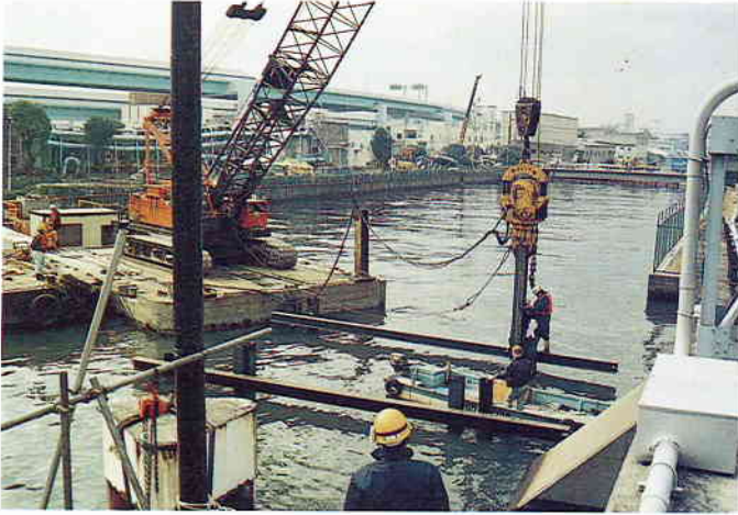
写真-7 運河の閉め切り工事
