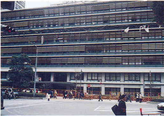
写真 - 1 被害を受けた神戸市第二庁舎
