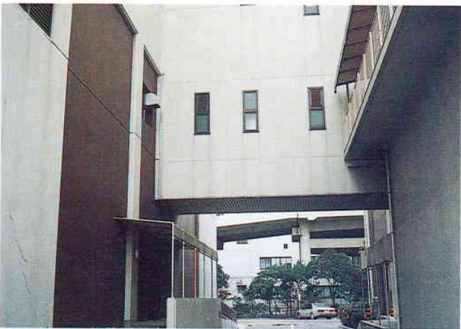
写真-11 ポートアイランド下水処理場
