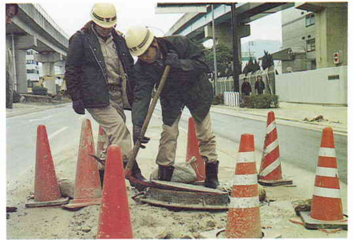
写真-18 下水管の調査
