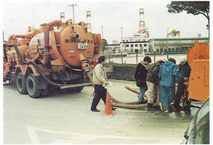
写真-16 下水管の調査
