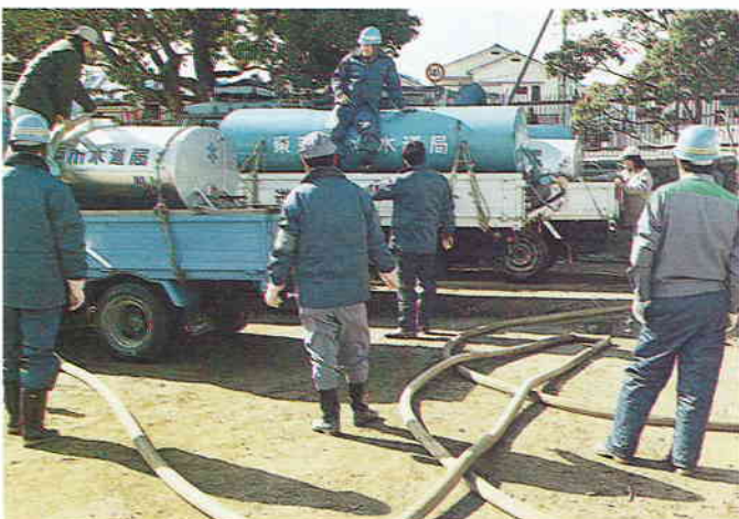
写真-23 配水場での給水車への水の搬入
