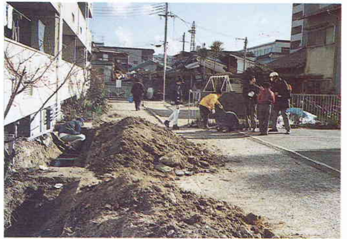
写真-20 アパートの下水管工事風景
