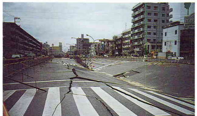
写真8 陥没による損壊
