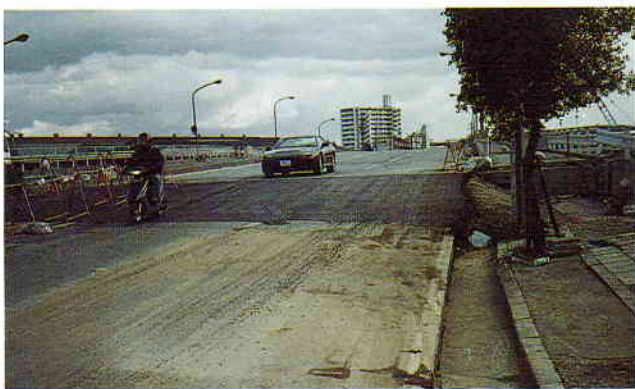
写真1 橋台背後の路面すり付け状況
