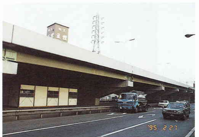
写真 16 豊中南インターチェンジ付近(ノージョイント工法)
