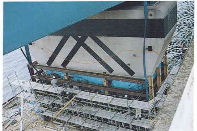
写真 20 第 2 摩耶大橋の橋脚部の修復
