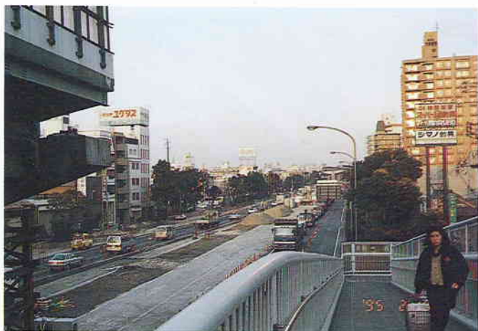
写真1 国道43号線（深江付近）
