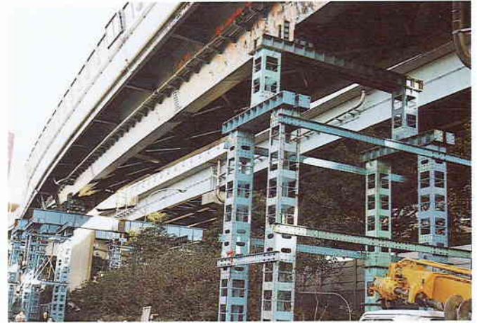
写真 8 上部工の落橋防止(1)
