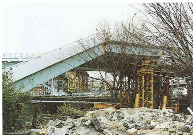
写真 9 上部工の橋脚防止(2)
