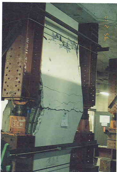
写真 21 神戸市営地下鉄上沢駅構内の中柱
