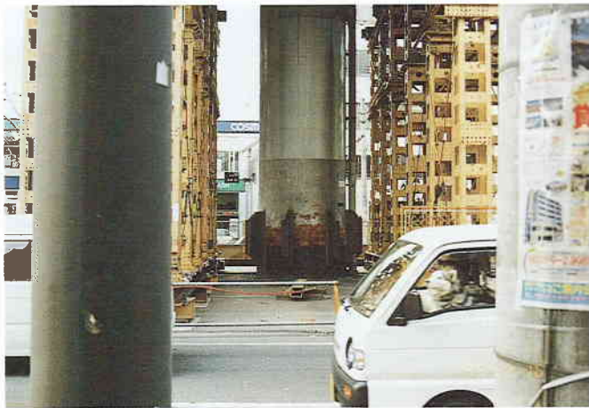
写真 7 鋼製橋脚の修復
