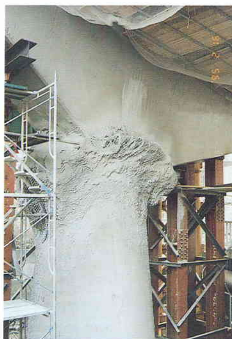
写真4 コンクリート製橋脚のモルタル吹き付け
