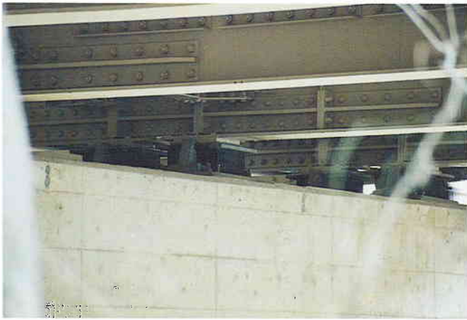
写真 17 生瀬高架橋の免震支承
