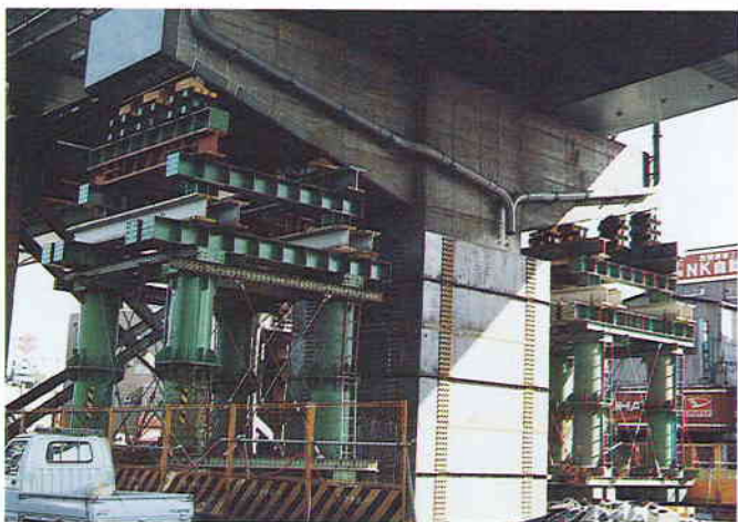
写真3 コンクリート製橋脚の修復
