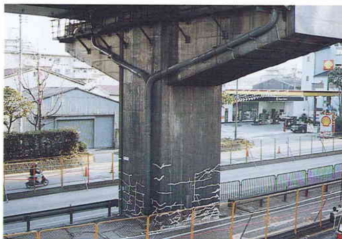
写真2 コンクリート製橋の樹脂注入による修復
