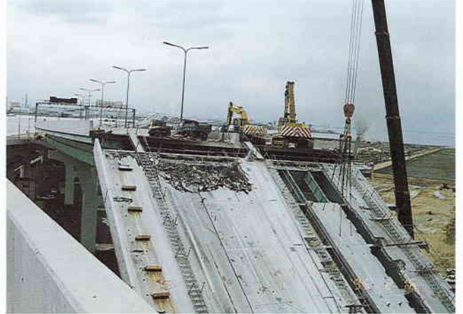
写真 12 西宮港大橋の側径間部の床版の撤去
