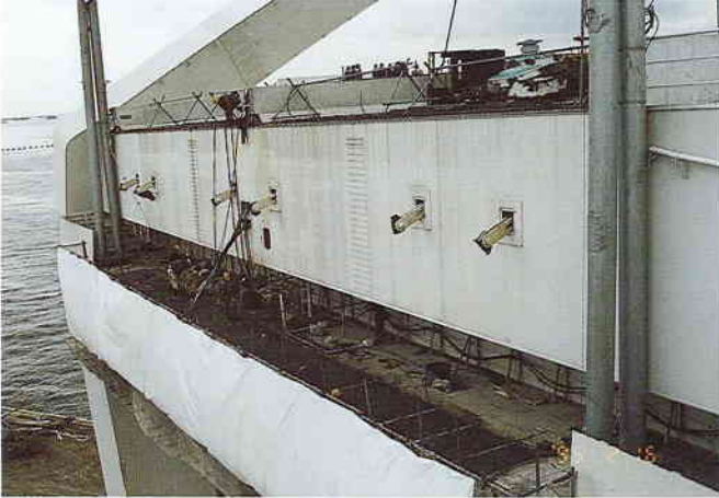
写真 11 西宮港大橋の側径間の修復状況
