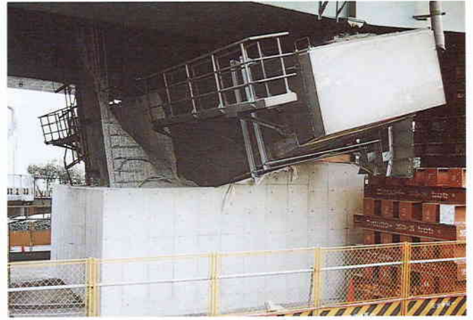
写真 6 コンクリート製橋脚の倒壊防止(2)
