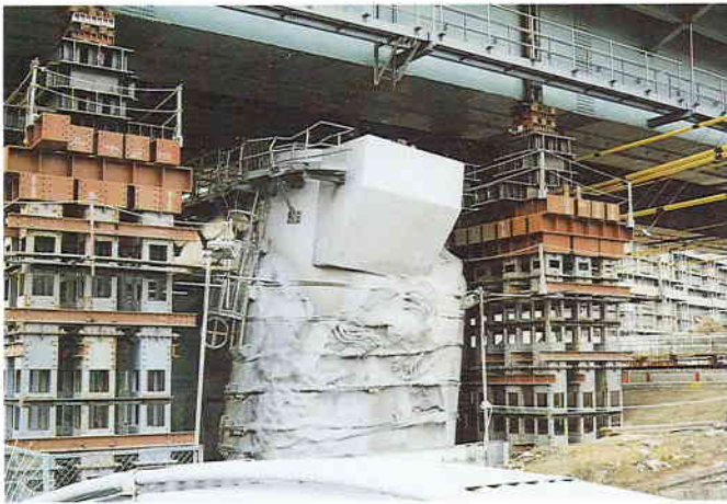
写真 5 コンクリート製橋脚の倒壊防止(1)
