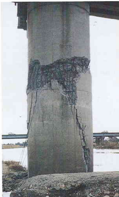
写真-1 矢印の先の柱がこの方向の面でせん断破壊している。
