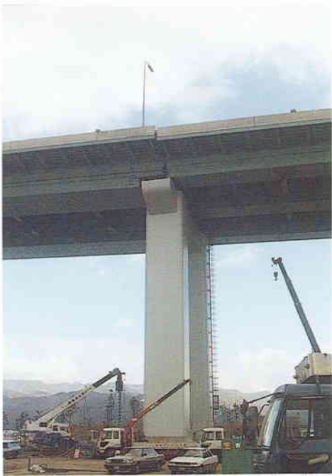
写真-7 阪神高速湾岸線橋梁基礎の 水平移動（南芦屋浜埋立地西護岸）
