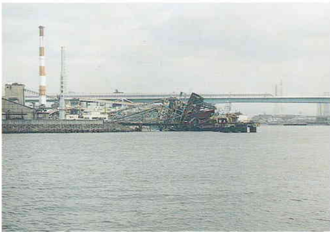
写真-3 尼崎港内におけるクレーン倒壊
