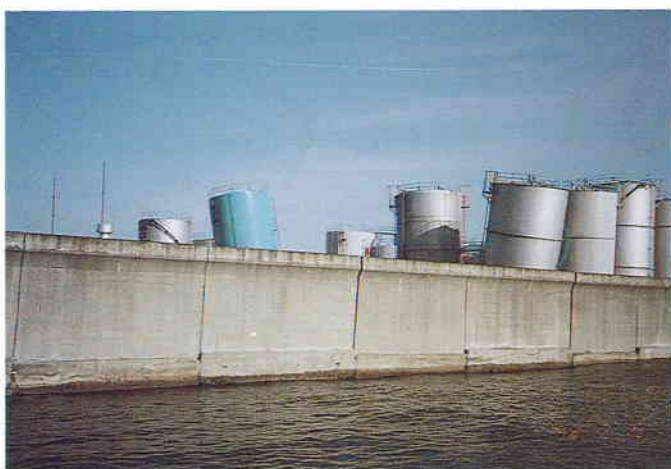
写真-11 長田港内小型石油タンクの傾斜
