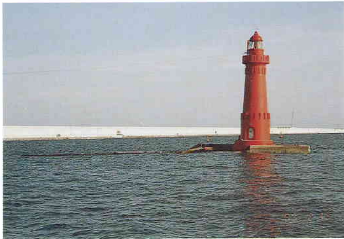
写真-9 ポートアイランド防波堤の沈下
