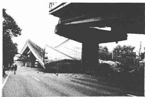
写真-1 高架橋の桁落ち (阪神高速道路神戸線)
