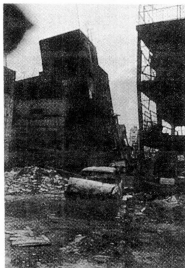
写真-8 火災による延焼と細街路の通行不能
