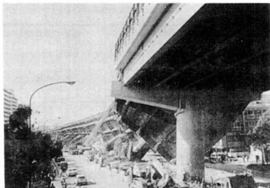
写真-6 阪神高速道路の倒壊
