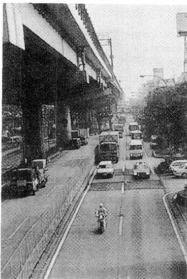
写真-5 交通規制後の国道43号線のバス専用ルート
