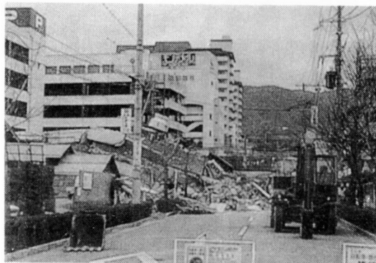
写真-7 建物崩壊による道路通行不能
