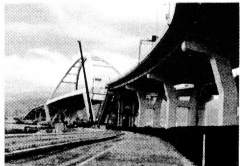
写真6-4 側方流動による落橋
