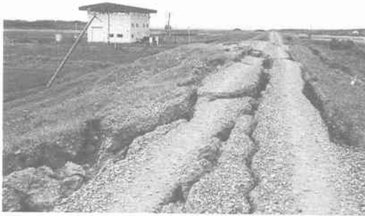
写真 6.2.1 (後志利別川) KP 0.865~0.980 兜野地先左岸築堤被災状況
