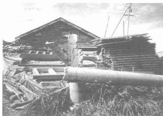
写真 11.2.6 津波により折れた電柱(奥尻島)
