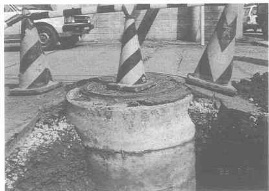
写真 11.3.2 調査地点 1 における調査状況 (測点 No.7 における掘削状況，下水マンホール M3 の相対的浮上量 16 cm) 8)
