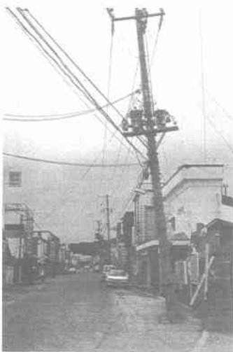
写真 11.2.4 地盤の液状化による電柱の埋没 (上磯町, 北海道電力から写真提供)
