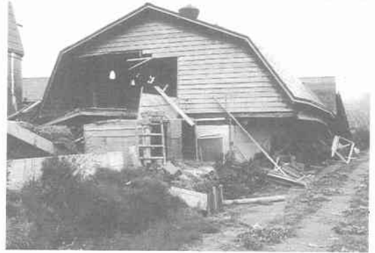
写真 12.4.6 大野町市渡、木造牛舎（小屋裏にロールした干し草を積んだ畜舎の倒壊，写真提供：大野町）
