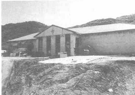
写真 12.2.25 稲穂小学校 (建物の写真左側が津波により破壊)
