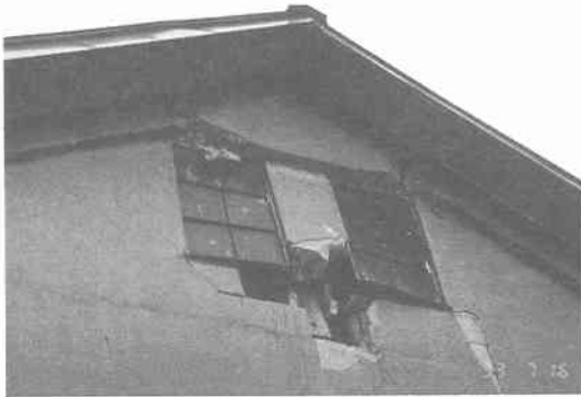
写真 12.3.29 厚沢部町館町 (CB 造平屋農業倉庫, 外壁と窓の破損, 写真提供: 井野智氏)
