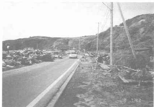
写真 12.3.12 北桧山町鵜泊（津波による被害）
