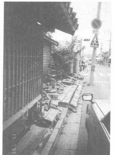
写真 12.4.7 上磯町久根別、木造住宅（液状化による傾斜，傾斜角13/1500）
