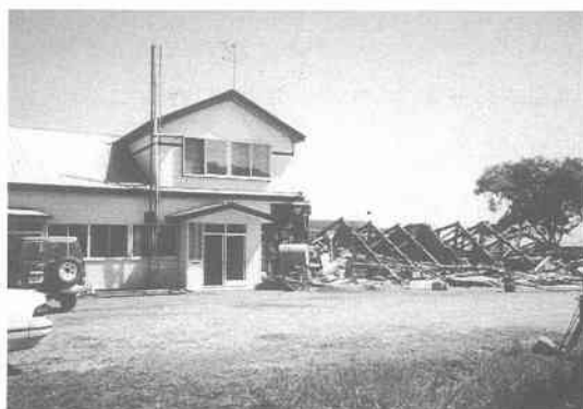
写真 12.5.19 車庫部分が完全に倒壊した木造事務所・車庫（撮影：宮澤健二氏）
