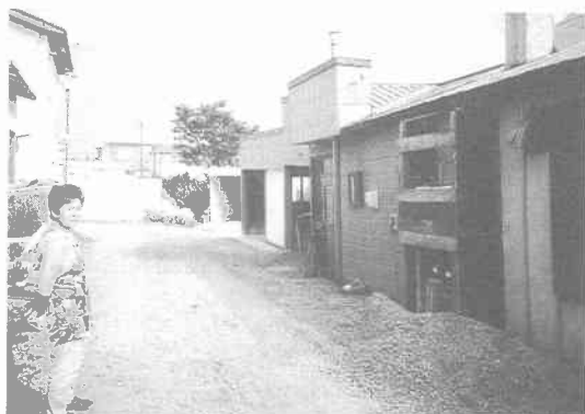
写真 12.3.16 北檜山町，真駒内川河岸の住宅 (液状化による沈下，約50cm)
