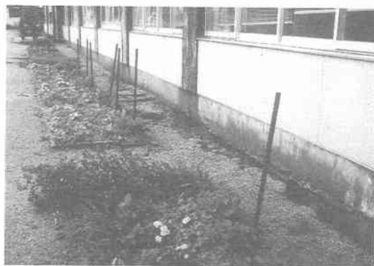
写真 12.2.6 奥尻中学校 19) （周辺地盤の沈下）
