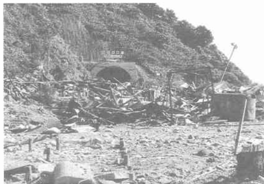
写真 12.3.13 北檜山町，日中戸トンネル現場 (津波による被害)
