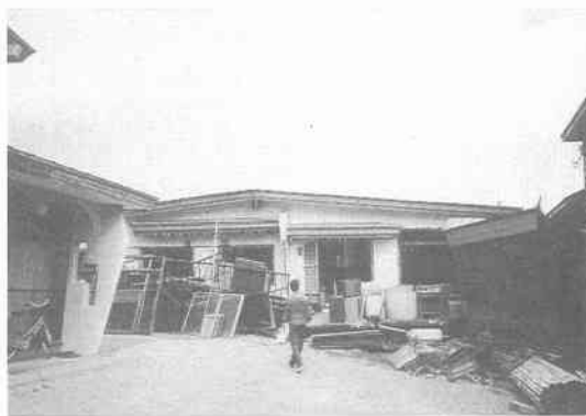
写真 12.3.7 乙部町（木造2階建住宅、壁量不足による倒壊）
