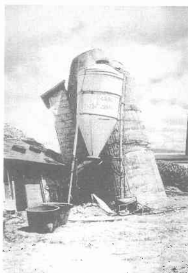
写真 12.3.18 北檜山町兜野 (液状化によるサイロ の傾斜，写真提供：北檜山町)
