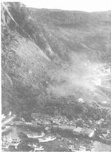
写真 12.2.1 宿泊施設「洋々荘」 39) (山崩れによる倒壊)
