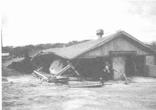
写真 12.2.23 畜舎 20) (木造平屋建ての畜舎が梁間方向に崩壊)
