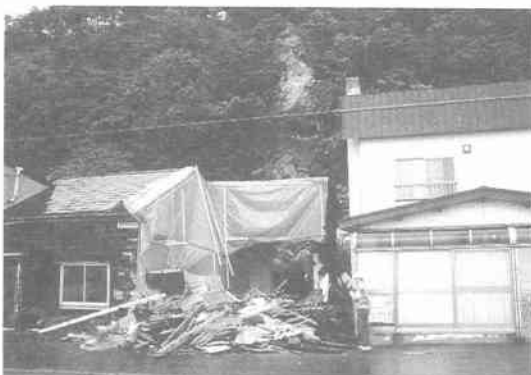
写真 12.3.24 島牧村豊浜 (木造平屋住宅, 落石による破損, 写真提供: 城攻氏)
