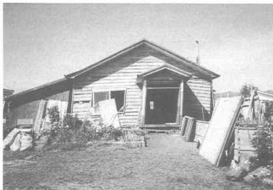
写真 12.5.18 著しい老朽化による強度不足のため被害を受けた木造住宅（撮影：宮澤健二氏）
