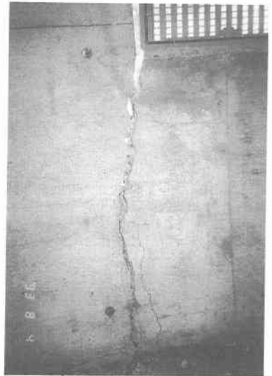
写真 12.5.22 布基礎の破断 (撮影：田村昌仁氏)
