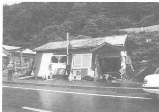
写真 12.3.22 島牧村原歌 (木造平屋住宅, 津波による破損, 写真提供: 城攻氏)
