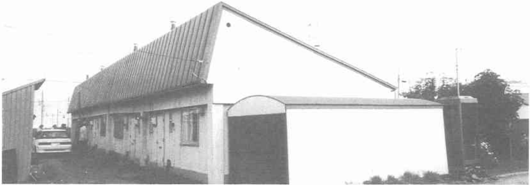
写真 12.5.9 新開町公営住宅団地
