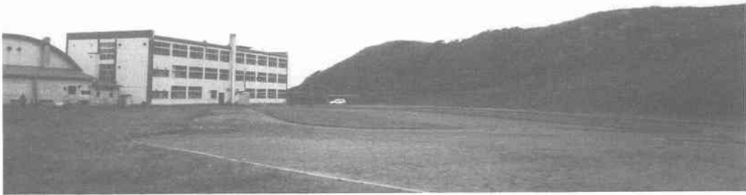
写真 12.2.10 青苗小学校 19) (右側の丘陵に崖崩れ)
