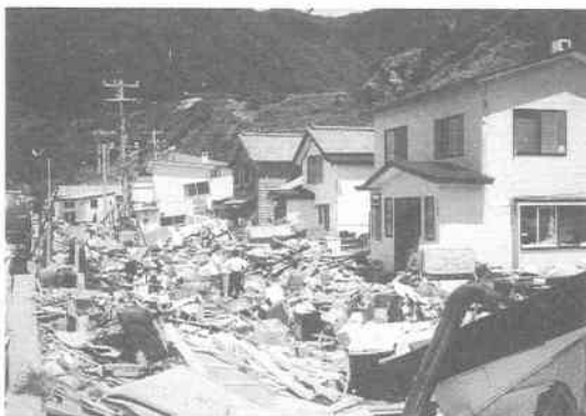
写真 12.3.9 大成町太田（津波による被害）
