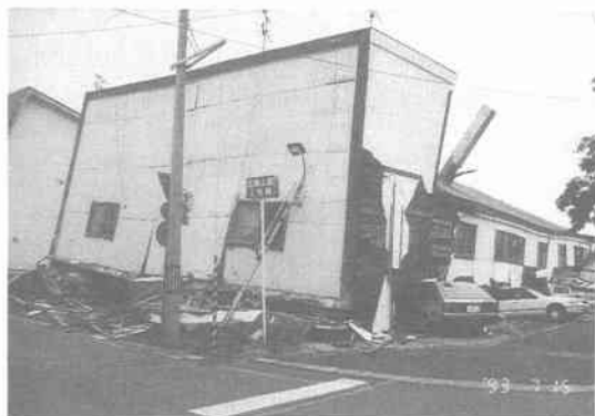
写真 12.3.14 北檜山町北檜山 (木造2階建てアパート， 壁量不足による倒壊，写真提供：瀬戸口剛氏)
