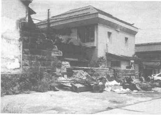
↑写真12.3.27 小樽市錦町（石塀、 H=3\text{m} 、石塀の倒壊、写真提供：城攻氏）
