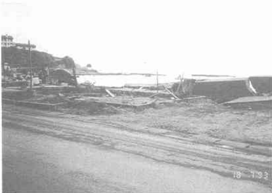
写真 12.3.11 北桧山町太櫓（津波による被害）
