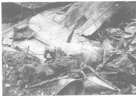
写真 13.3.4 火災現場の LP ガスボンベ
