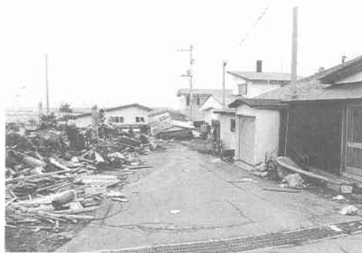
写真 13.3.3 南側焼け止まり線となった場所（道路反対側の住戸の窓が破られており、外壁・屋根の塗装が溶解している）
