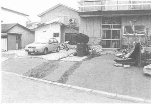
写真 13.1.4 転倒し灯油が漏出したと見られる灯油タンク
